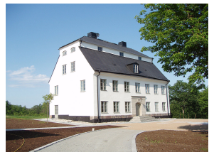
Marums gårds huvudbyggnad, exteriört renoverad under 2008-2009. Foto: Juli 2009.
